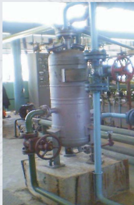
Схема и теплообменный аппарат ТА-4,2Р-4, совмещенный с сепаратором, для охлаждения сжатого воздуха водой. Мощность 215 кВт, P_{\text{раб.}} = 7,0 \text{ МПа}
