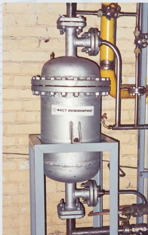
Изотермический реактор паровой конверсии CO
