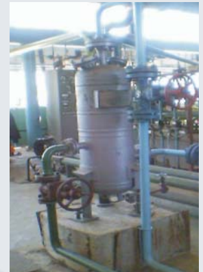
Схема и теплообменный аппарат ТА-4,2Р-4, совмещенный с сепаратором, для охлаждения сжатого воздуха водой. Мощность 215 кВт, P_{\text{раб.}} = 7,0 \text{ МПа}
